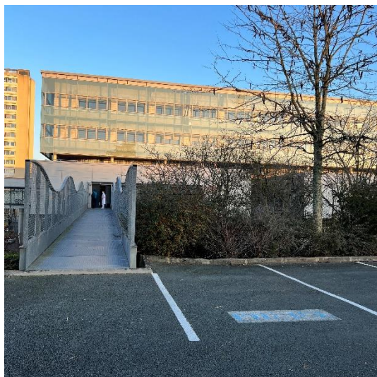
Passerelle d'accès réservé
