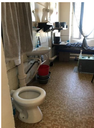
Cellule du 3 ème étage du bât. C
