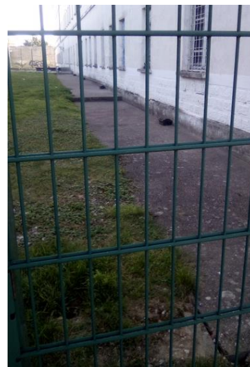
Abords du bâtiment C
