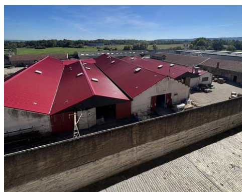
La réfection de la couverture des ateliers est récente
