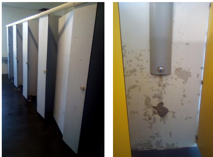
Un bloc de douches du bâtiment A
