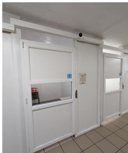
Vue latérale d'une cabine de parloir
