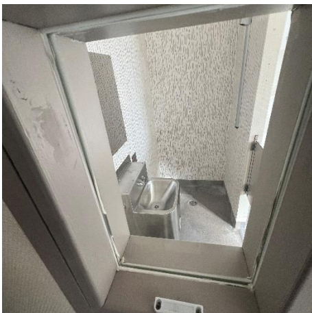
Vue depuis l'extérieur de la chambre
