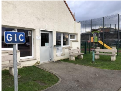
Entrée de l'abri des familles avec les bancs extérieurs non abrités
