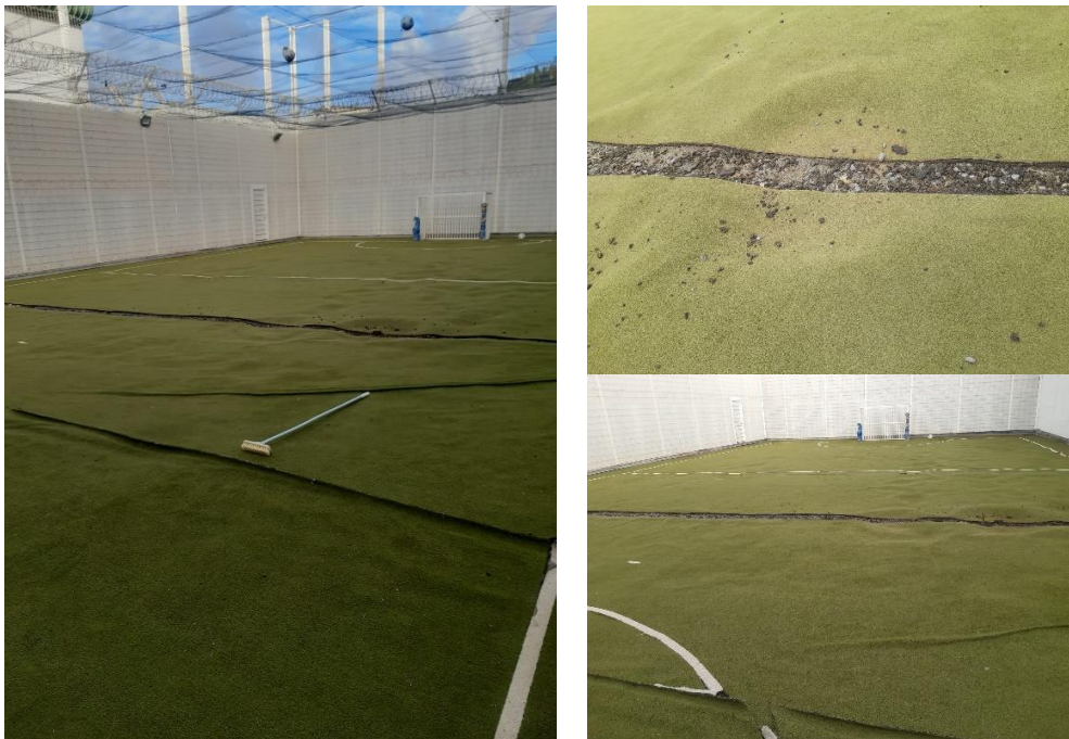
Revêtement du terrain de sport
