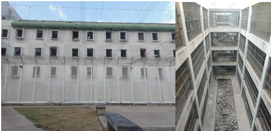
Vue du CD depuis la cour de promenade et vue intérieure du CD depuis le 3 ème étage
