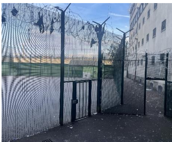
Accès aux cours de promenade et cour grise
