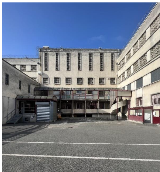
Une partie du bâtiment principal
