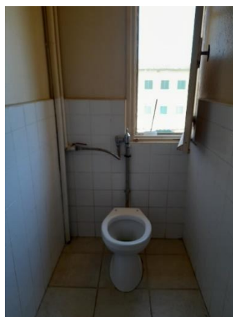
Les toilettes du bâtiment C
