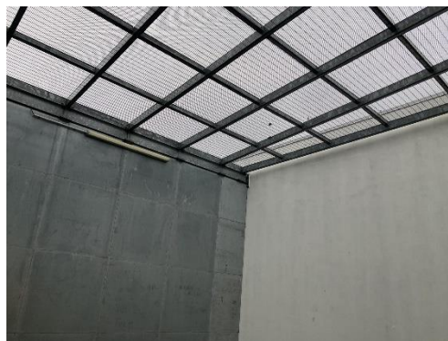
Barreaudage, cour de promenade du QI
