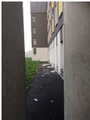
Abords des bâtiments
