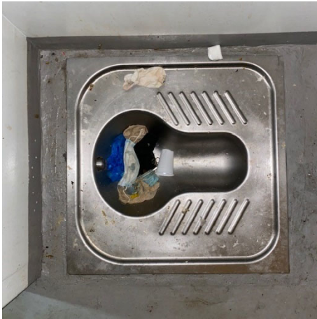
WC d'une cellule de dégrisement
