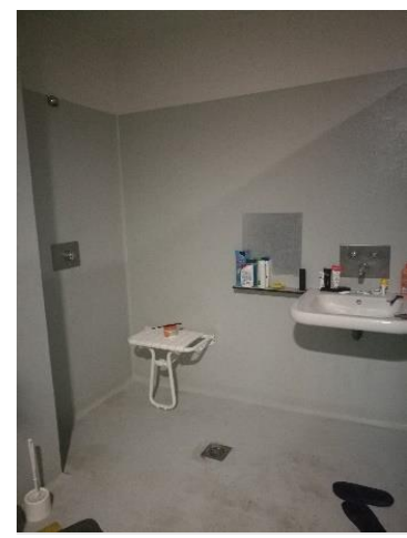
Sanitaires cellule PMR
