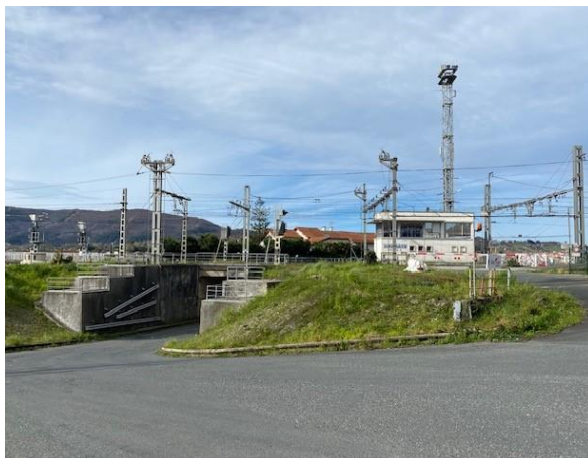
Entrée du tunnel d'accès au CEF
