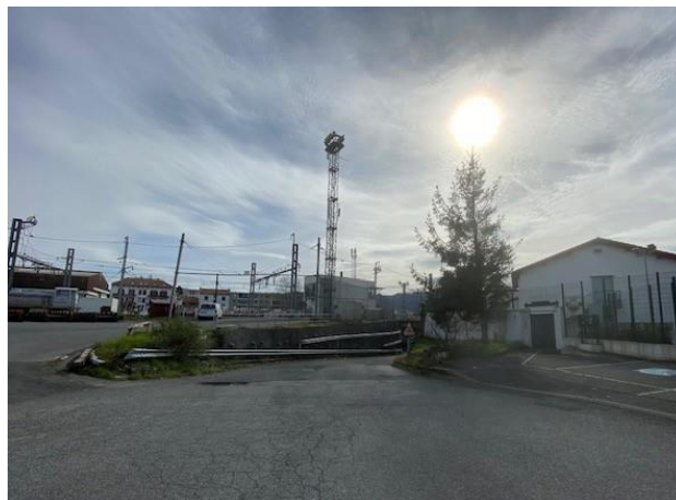
Sortie du même tunnel coté CEF
