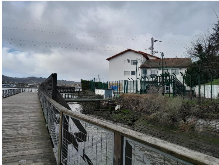
Accès au CEF via une passerelle
