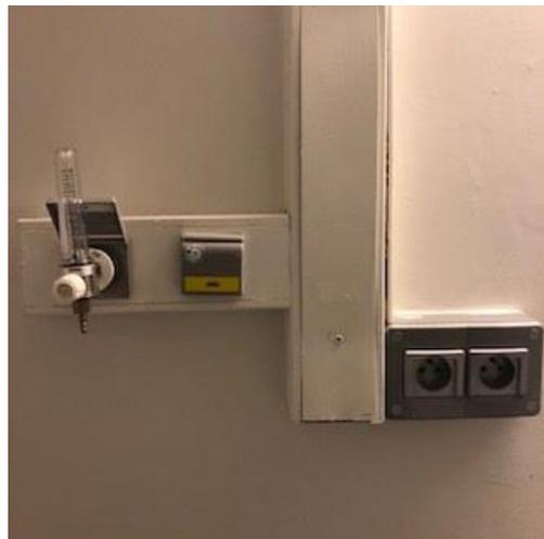
*Dispositif d'alimentation du box en oxygène, vide et électricité*
