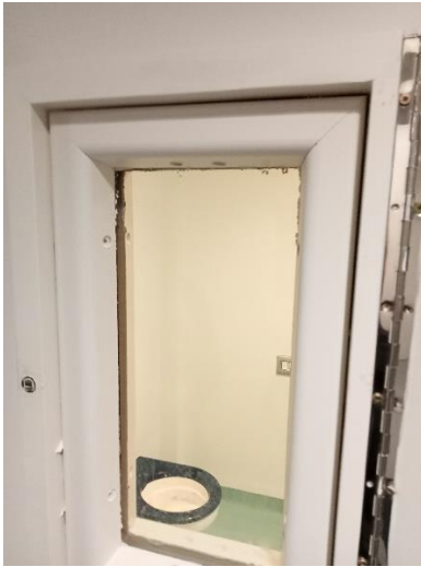
Fenestron donnant sur les toilettes de la CI de l'UISI
