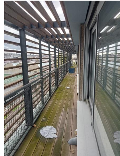
Balcon accessible depuis un sas des CI de l'UISI
