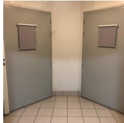
Portes d'accès aux sanitaires dans un sas
