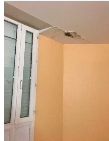
Dans une chambre : lit, lavabo de la salle d'eau individuelle, plafond dégradé par des infiltrations
