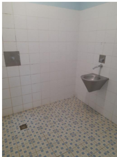
Chambre équipée d'une douche et d'un lavabo
