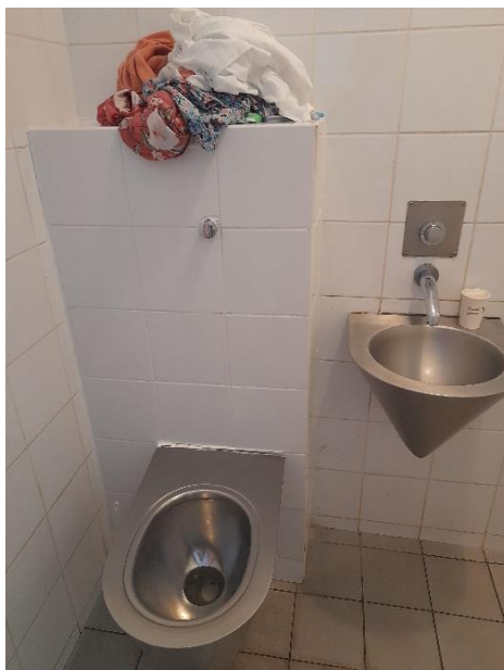
Bloc sanitaire d'une chambre
