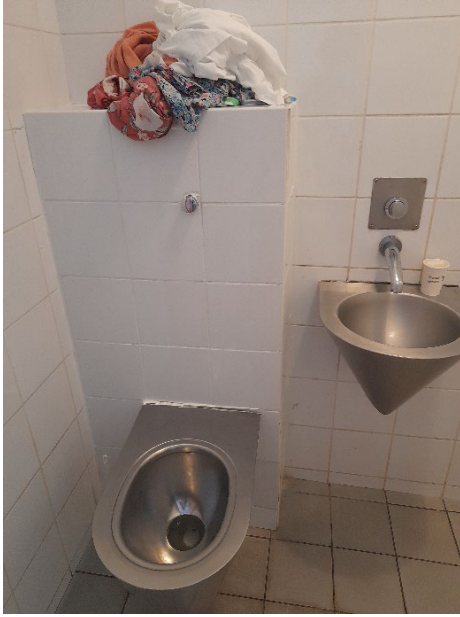
Bloc sanitaire d'une chambre
