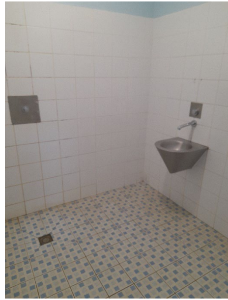
Chambre équipée d'une douche et d'un lavabo
