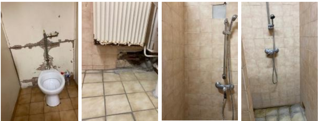
Aperçus des locaux sanitaires au rez-de-chaussée du QSL
