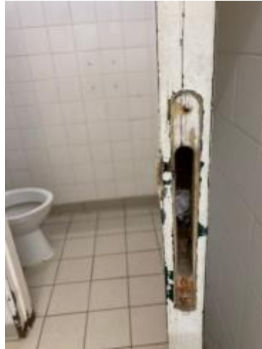
WC des auxiliaires de cuisine
