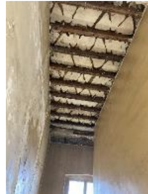
Plafond escalier, D2
