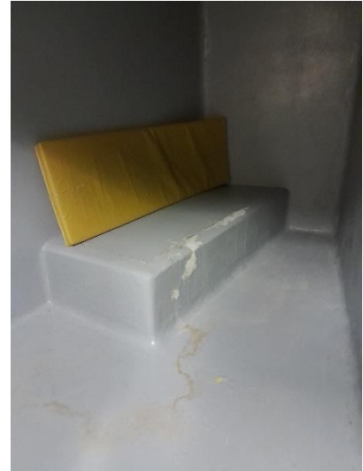
Les cellules de garde à vue soumises à des infiltrations d'eau sale
