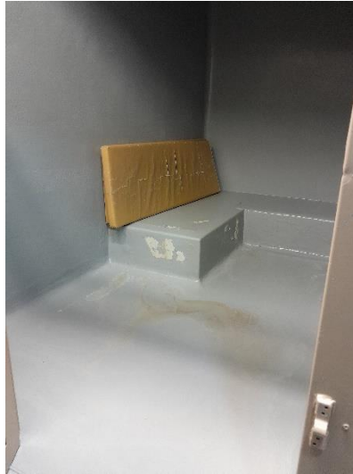
Les cellules de garde à vue soumises à des infiltrations d'eau sale
