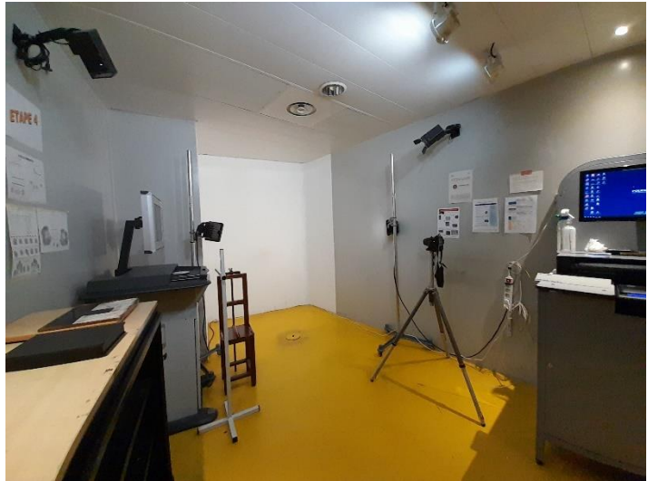
Le local de signalisation
