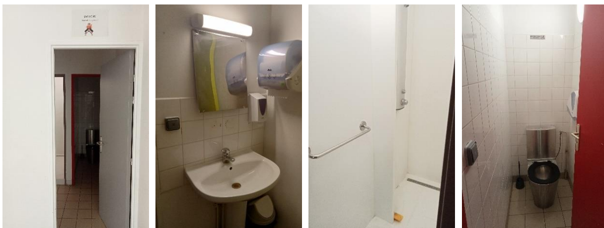
Sanitaires collectifs des garçons
