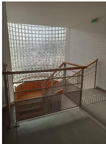
Escalier d'accès aux chambres
