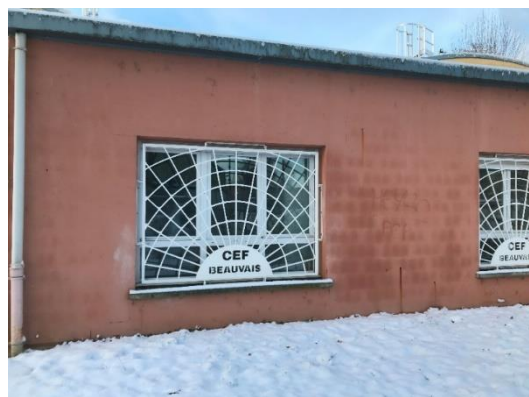
La ferronnerie en façade
