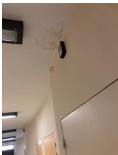
*Infiltration d'eau au plafond à Délos*
