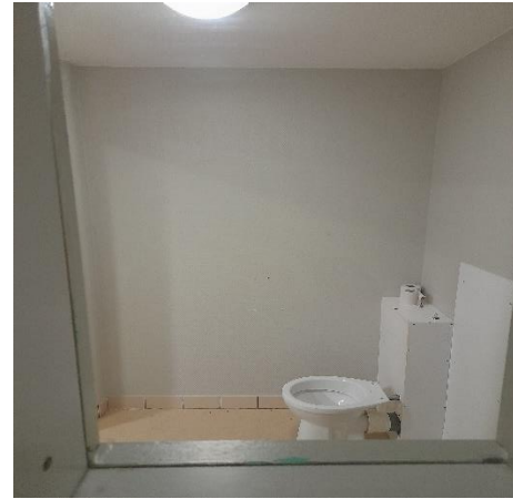
Vue des toilettes à travers la fenêtre du sas de Toria
