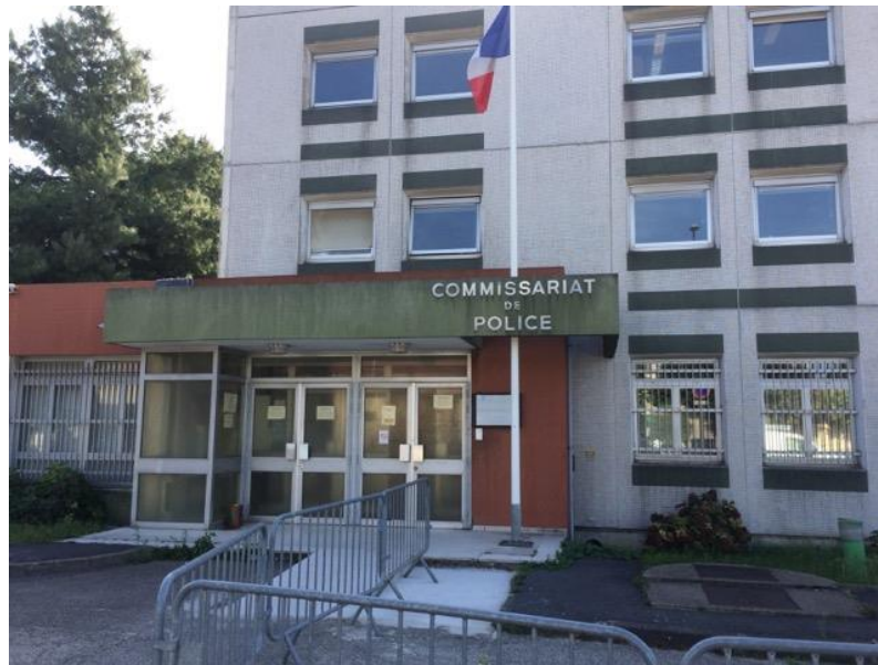
Figure 1 : Entrée publique du commissariat de police de Maisons-Alfort
