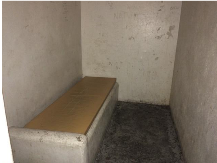
Figure 4 : Intérieur de l'une des deux geôles
