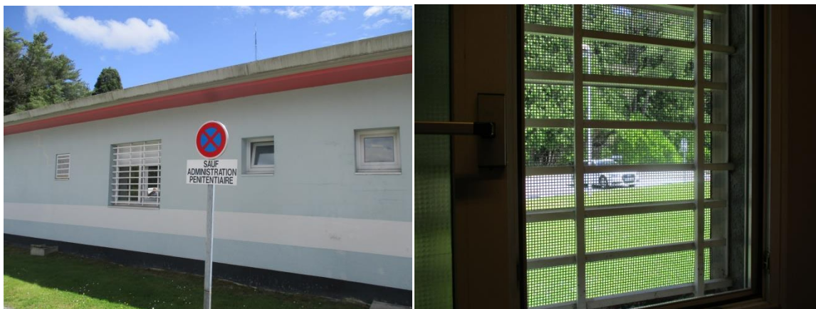
La fenêtre de la salle de garde, similaire à celle de la chambre sécurisée, vue de l'extérieur et de l'intérieur
