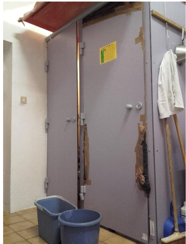
Fuite au plafond d'une cellule, protection et seaux de récupération de la fuite
