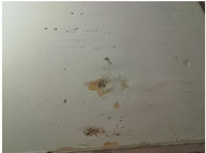
Détériorations de structure dues à l'humidité
