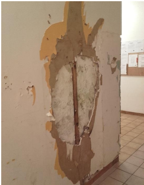
Détériorations de structure dues à l'humidité
