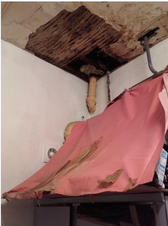
Fuite au plafond d'une cellule, protection et seaux de récupération de la fuite
