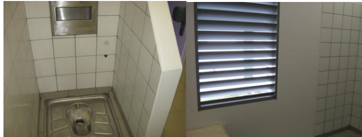
Côté sanitaire d'une chambre de mise à l'écart
