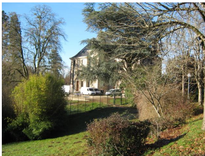
Vue du bâtiment principal
