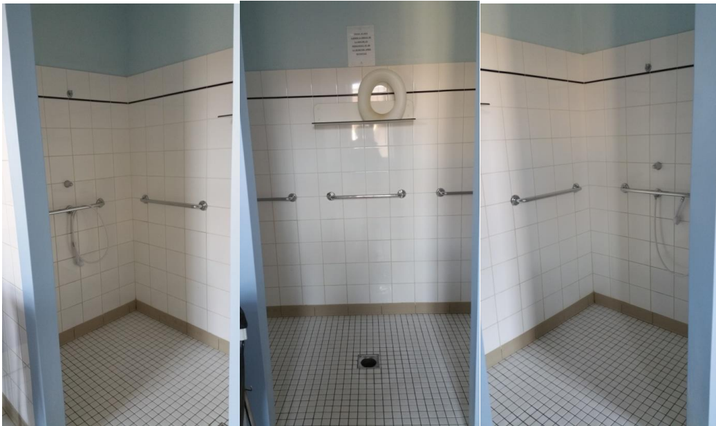
Les deux douches sans séparation
