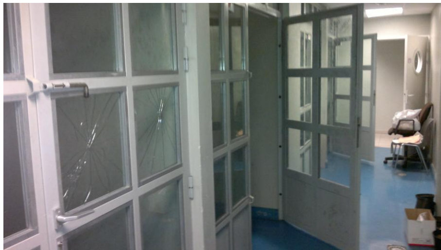
Un des espaces de la sûreté départementale comprenant des cellules de garde à vue
