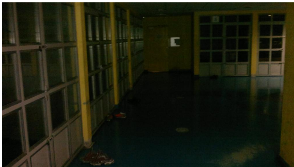
Vue sur les cellules du dépôt de sûreté à partir de la zone de circulation
