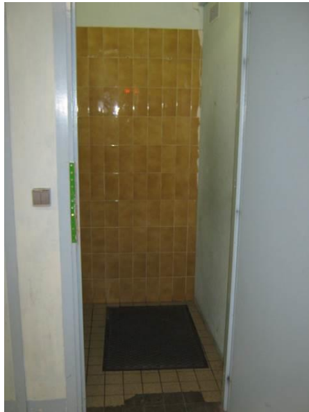
Box de fouille
