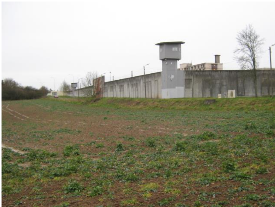
Vue sur la façade Est
