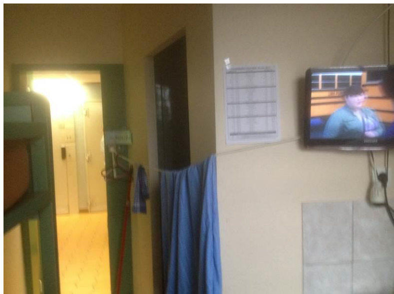
Vue d'une partie d'une cellule rénovée, le câble de télévision sert de sèche-linge et de support aux éléments de lingerie qui isolent les sanitaires du reste de la cellule
