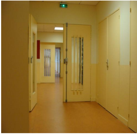
Hall de l'étage supérieur desservant, de part et d'autre, les deux couloirs d'hébergement.
